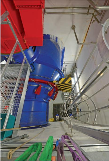
Bild 10: Dotier-KW Leitapparat zur Kaplan-Rohrturbine
