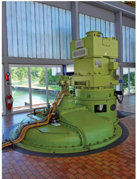
*Bild 6: Vertikal-Kaplanturbine mit BBC-Generator Baujahr 1932*
