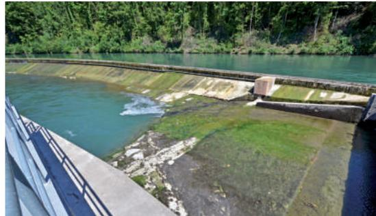
Bild 13: Korrigierter Fallboden, für die Schifffahrt wieder i.O.
