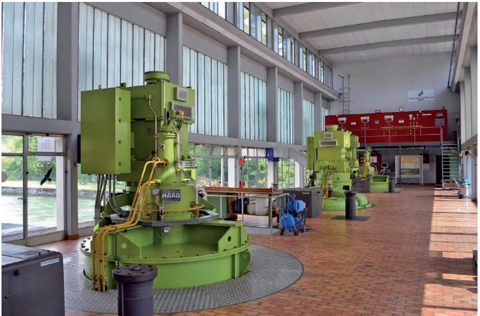
Bild 4: Maschinensaal mit den 3 Vertikal-Kaplanturbinen
