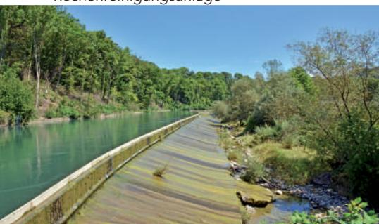
*Bild 8: Oberwasserkanal mit Streichwehr*
