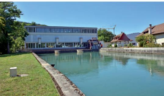
*Bild 7: Maschinenhaus mit automatischer Rechenreinigungsanlage*
