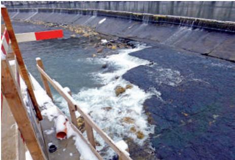
Bild 12: gefährlicher Fallboden für die Schifffahrt nach baulichen Eingriffen
