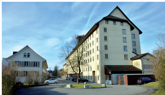
Bild 7: Ehem. Spinnerei mit Nebengebäude 2018
