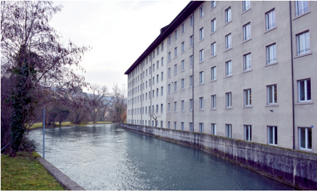
Bild 10: Spinnerei mit Oberwasserkanal und Schutzmauer 2018
