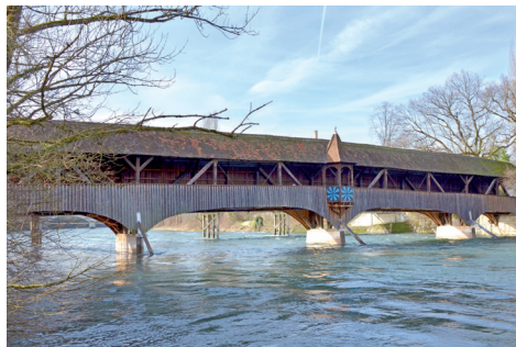
Bild 9: Holzbrücke Turgi, 1921 erbaut
