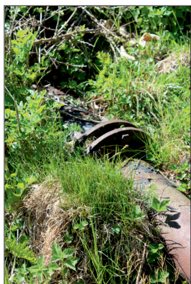
Particolare della condotta
