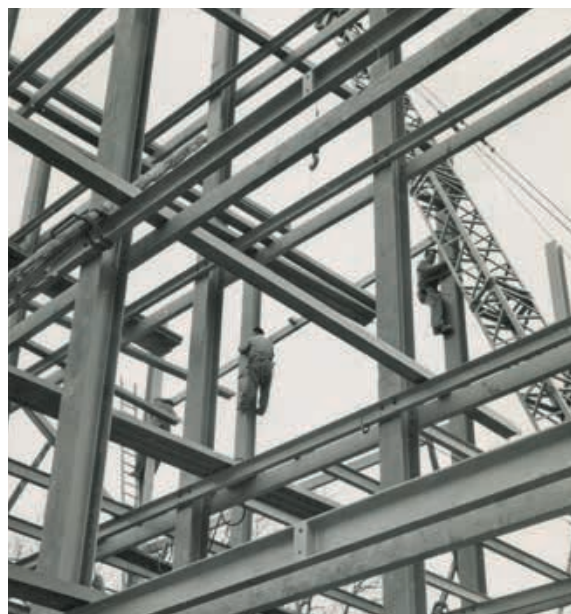
Der Wohnturm von Annemarie Hubacher während der Aufbauarbeiten (gta Archiv)
