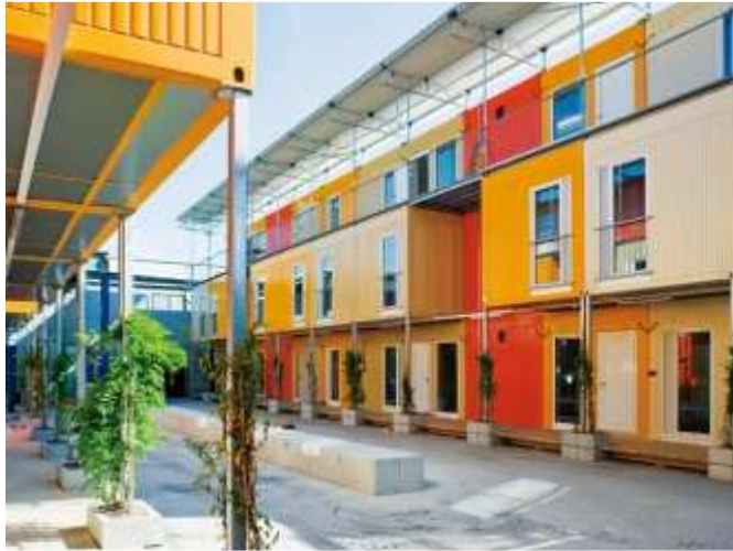
Temporäre Wohnsiedlung Leutschenbach
