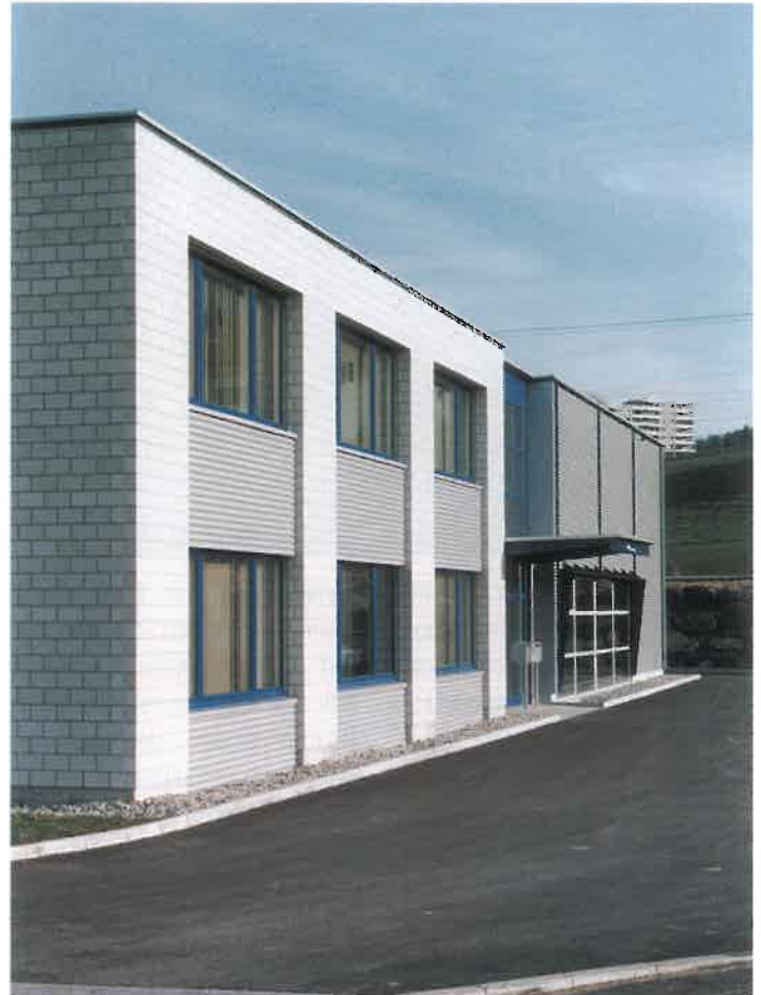
Zweigeschossiger Bürotrakt in Sandkalkstein-Mauerwerk
