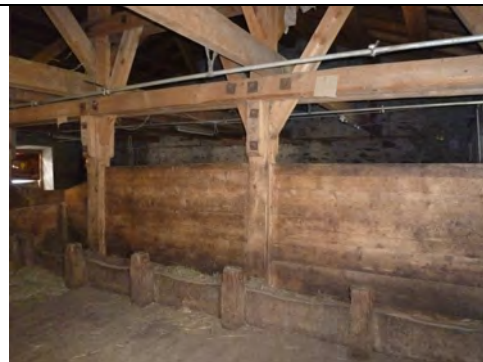
Älterer Stall, nach 1964 im Zusammenhang mit Umrüstung auf Melkmaschine umgebaut von 5 auf 4 Stallabteile. Pfettendach durch Zangenbinderkonstruktionen unterstützt. Viehstände aus Bohlen, Mittellängsgang.
