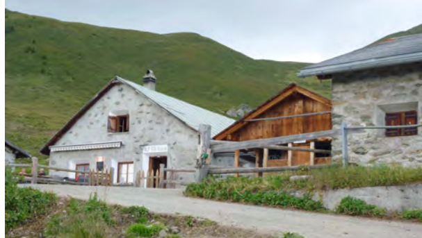
Obere Sennhütte (Vers.-Nr. 100) mit Hütte für Melkaggregat. Rechts jüngerer Stall von ca. 1964. Bau unter Einsatz einer mobilen Säge, betrieben durch Giovanin Janett, Tschlin.
