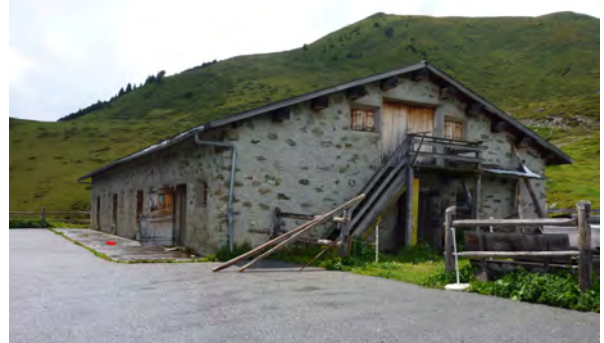
Älterer Stall, nach 1964 im Zusammenhang mit Umrüstung auf Melkmaschine umgebaut von 5 auf 4 Stallabteile. Pfettendach durch Zangenbinderkonstruktionen unterstützt. Viehstände aus Bohlen, Mittellängsgang.
