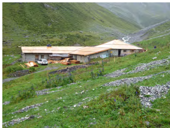
Alp Urezzas (Ardez, 2111 m ü. M.). Renovation 2010, Neueindeckung mit zweilagigen Lärchenbrettern. (Foto B. Furrer 2010)
