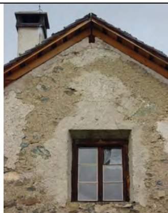
Giebel Ost mit Bauinschrift 1897, in Verputz eingekratzt
